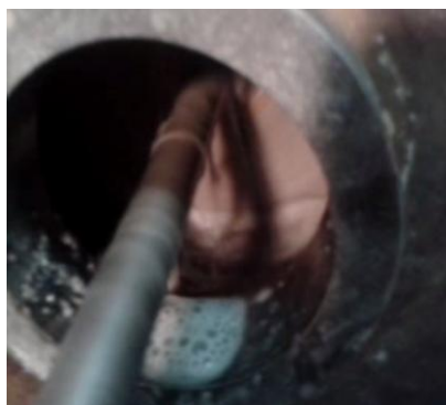
Figura 13 Vista interna del dispositivo en funcionamiento
